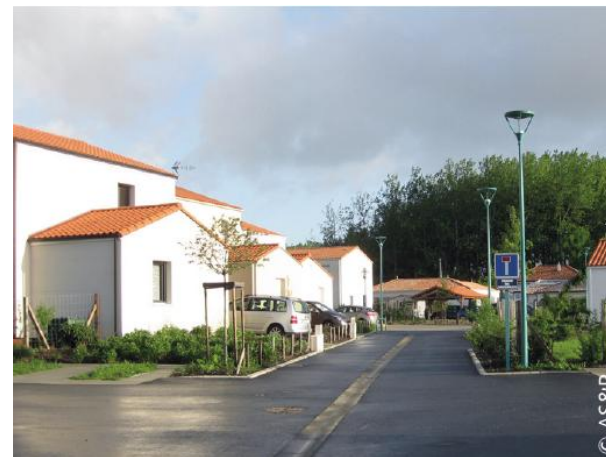
Voie partagée, sans issue, qui se termine en espace public
