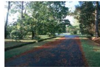
voirie et fossés latéraux
