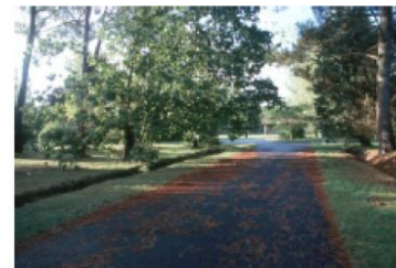
voirie et fossés latéraux
